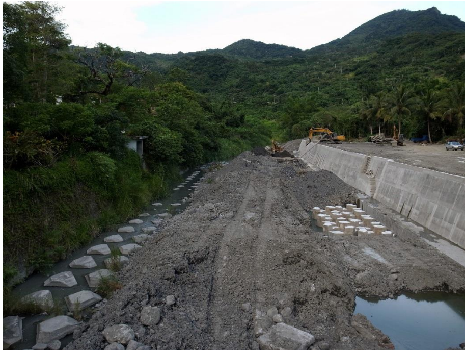
河岸的植被被剷除，築起高牆。
