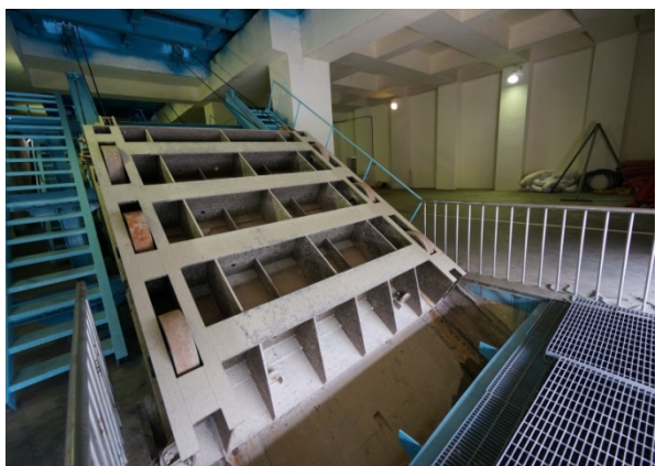
水庫水工設施
