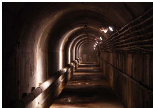
水庫監測隧道
