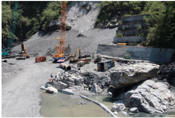
谷關大橋邊河川整治工程
